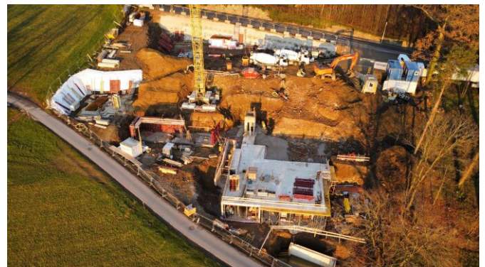
Baufortschritt Anfang Dezember 2024
