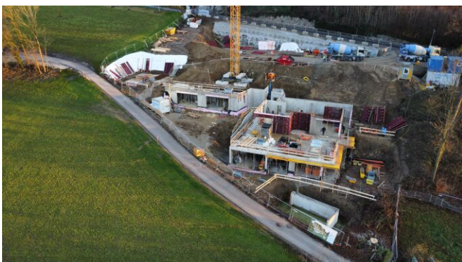
Baufortschritt Mitte Dezember 2024
