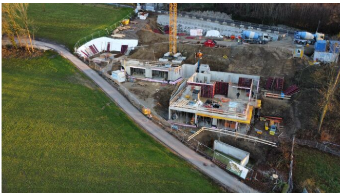
Baufortschritt Mitte Dezember 2024
