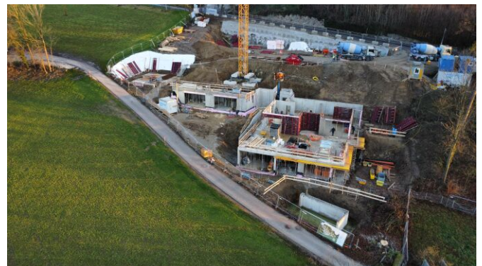
Baufortschritt Mitte Dezember 2024
