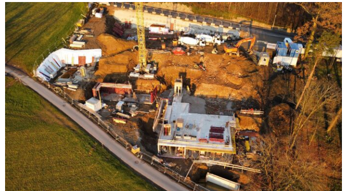
Baufortschritt Anfang Dezember 2024
