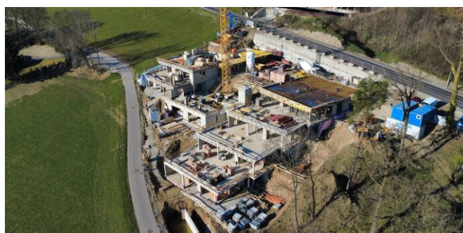
Baufortschritt Mitte März 2025
