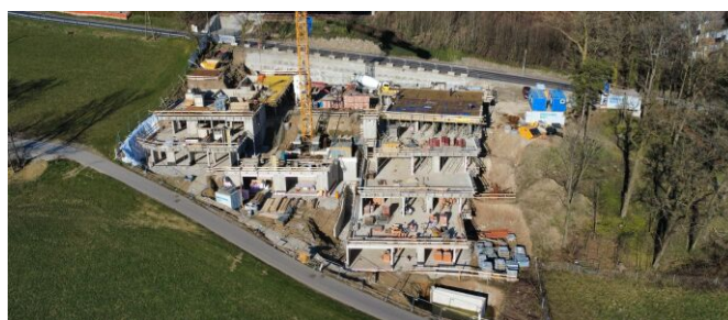
Baufortschritt Mitte März 2025
