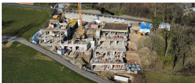
Baufortschritt Mitte März 2025
