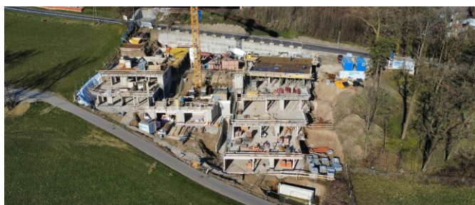
Baufortschritt Mitte März 2025
