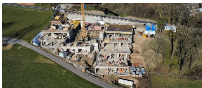
Baufortschritt Mitte März 2025
