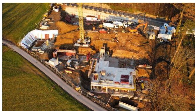
Baufortschritt Anfang Dezember 2024
