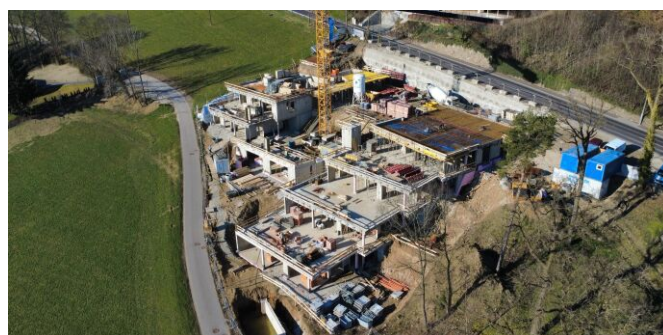
Baufortschritt Mitte März 2025
