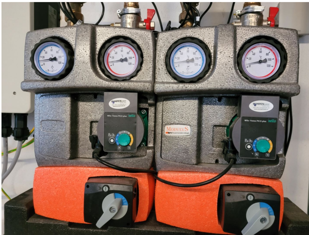
Pumpengruppe gedämmt.jpg
