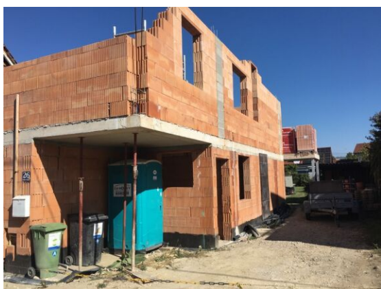
Baufortschritt - Rohbau wird demnächst fertig!
