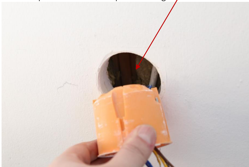
Foto beispielhaft: kein Innenputz am Ziegel
