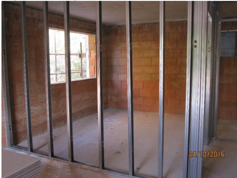
Foto beispielhaft: kein Innenputz am Ziegel
